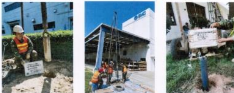
图 2 监测井钻探建井现场施工照片示意
