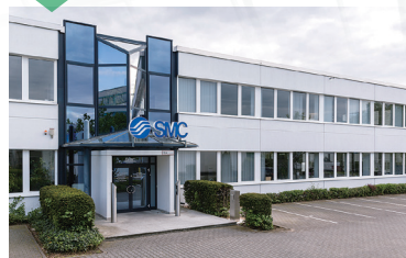
GTC 德国技术中心
